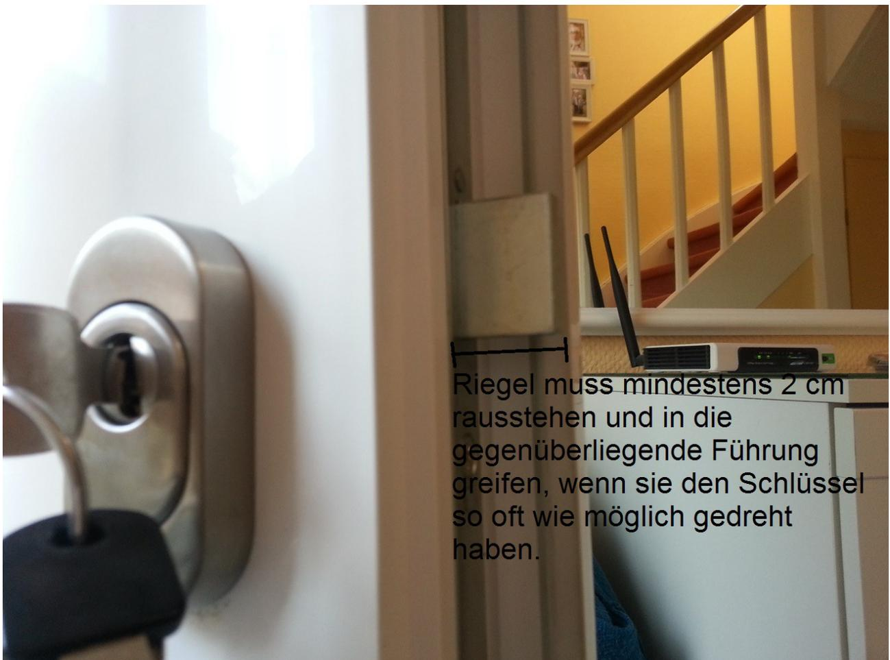
Riegel muss mindestens 2 cm rausstehen und in die gegenüberliegende Führung greifen, wenn sie den Schlüssel so oft wie möglich gedreht haben.
