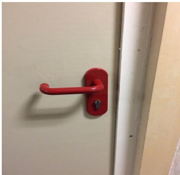
**falsch:** Blende ist aus Plastik und so mit einem Schraubenzieher leicht auszubrechen. Dann liegt der Schließzylinder komplett frei und kann gezogen werden.
